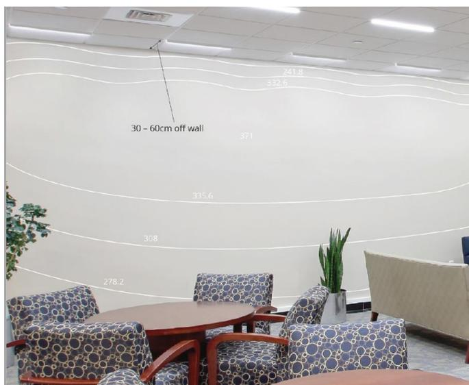
La version asymétrique permet une mise en valeur mural avec un éclairage uniforme du sol au plafond. En déportant le T-BAR à 30 – 60 cm du mur, la source lumineuse sera invisible par l'utilisateur.
